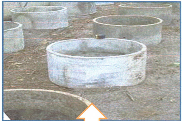
ขั้นตอนที่ ๒ จัดวางบ่อซีเมนต์ โดยทิ้งระยะให้ห่างกันพอสมควร
